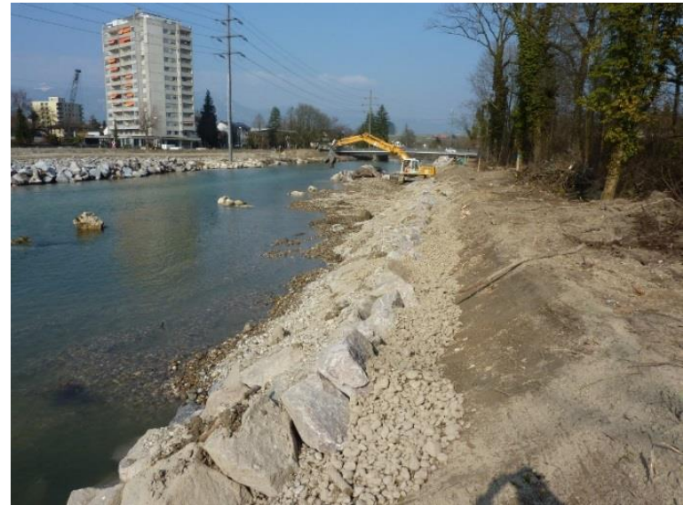
Neubau der Dämme
