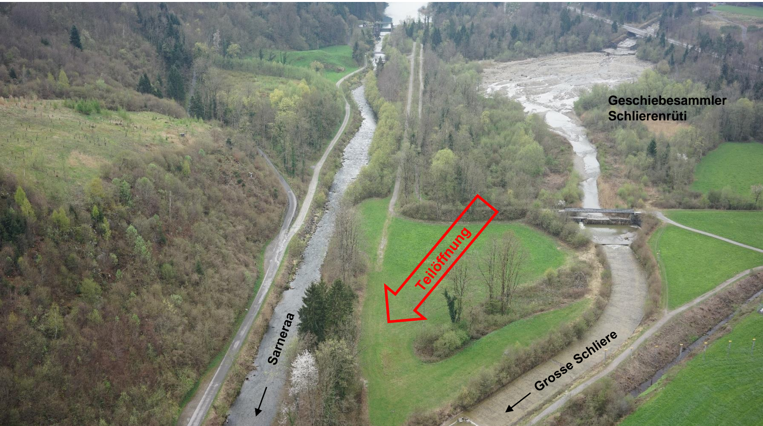
Ist-Zustand Sarneraa und Geschiebesammler Schlierenrüti (Bildquelle: Kanton Obwalden)
